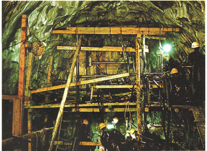
ဂျပန်နိုင်ငံ ဟွန်းရှူးကျွန်းနှင့် ဟော့ကိုင်ဒိုးကျွန်းတို့ကို ဆက်သွယ်ပေးမည့် ရေအောက်လိုဏ်ခေါင်းကို ဆောက်လုပ်နေစဉ်
