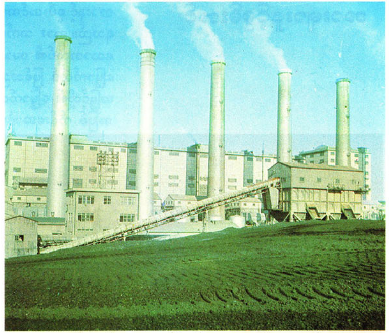
ရေနွေးငွေ့သုံးဓာတ်အားပေးစက်ရုံတွင် ရေနွေးငွေ့၏ အရွှေ့စွမ်းအင်ကို လျှပ်စစ်စွမ်းအင်ထုတ်လုပ်ရန် အသုံးပြုသည်။
