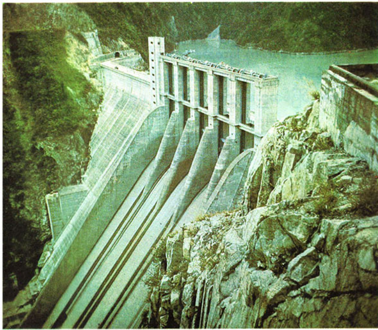
စီးဆင်းရေ၏ အရွှေ့စွမ်းအင်ကို အသုံးပြု၍ ရေအားသုံး ဓာတ်အားပေး စက်ရုံတွင် လျှပ်စစ်စွမ်းအင် ထုတ်လုပ်သည်။
